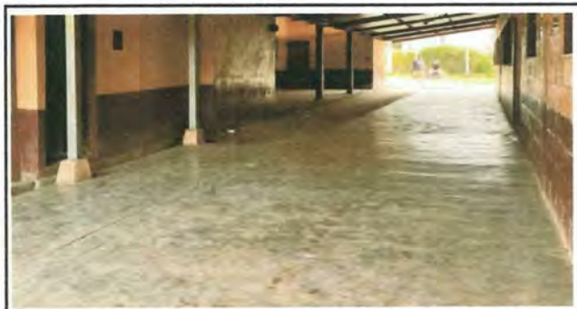
Foto 6: Se observa grietas, fisuras, descascaramiento y desgaste en piso, causados por el deterioro natural de los materiales, es por ello que se le colocara piso cerámico
