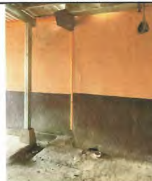
Foto 2: Instalación de tuberías de agua pluvial y caja de registro ya que los que se tienen ya no son funcionales.
