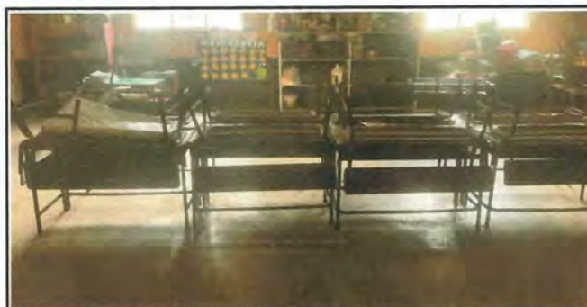
Foto 5: Se observa grietas, fisuras, descascaramiento y desgaste en piso, causados por el deterioro natural de los materiales y por la falta de mantenimiento. Es por ello que se colocara piso cerámico
